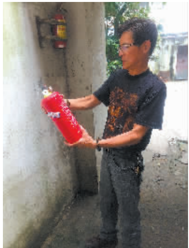
朱师傅正在检查楼道里的灭火器。(王伊婧 摄)
