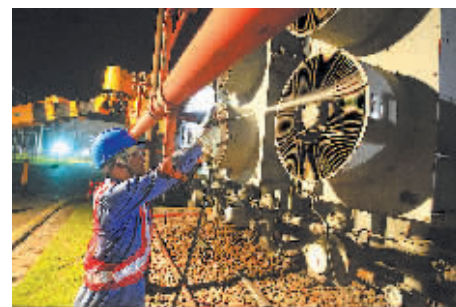
电力部门零点时分进行设备检修。(鄂晓刚 冯璋 摄)
