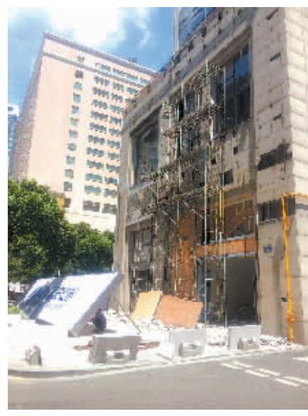
图为施工现场。(王伊婧 摄)
