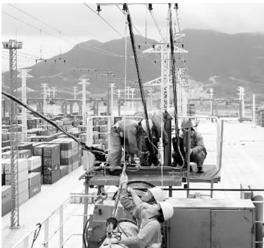
图为港吉公司技术人员正在对龙门吊“油改电”项目进行维护。(史碧君 摄)
