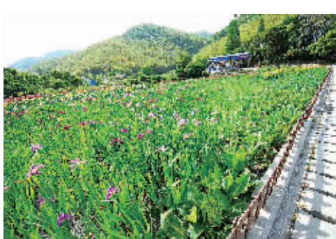
宛如花园的横溪村生活污水处理湿地
