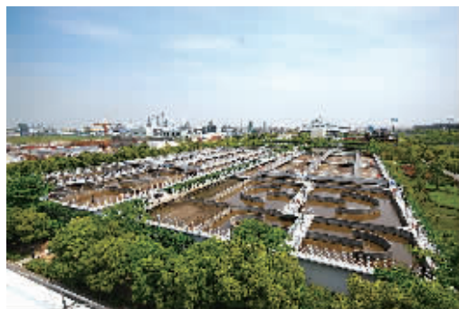
宁波北区污水处理厂二期
