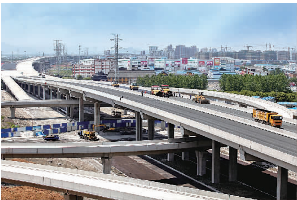
北外环快速路将在10月底建成。
