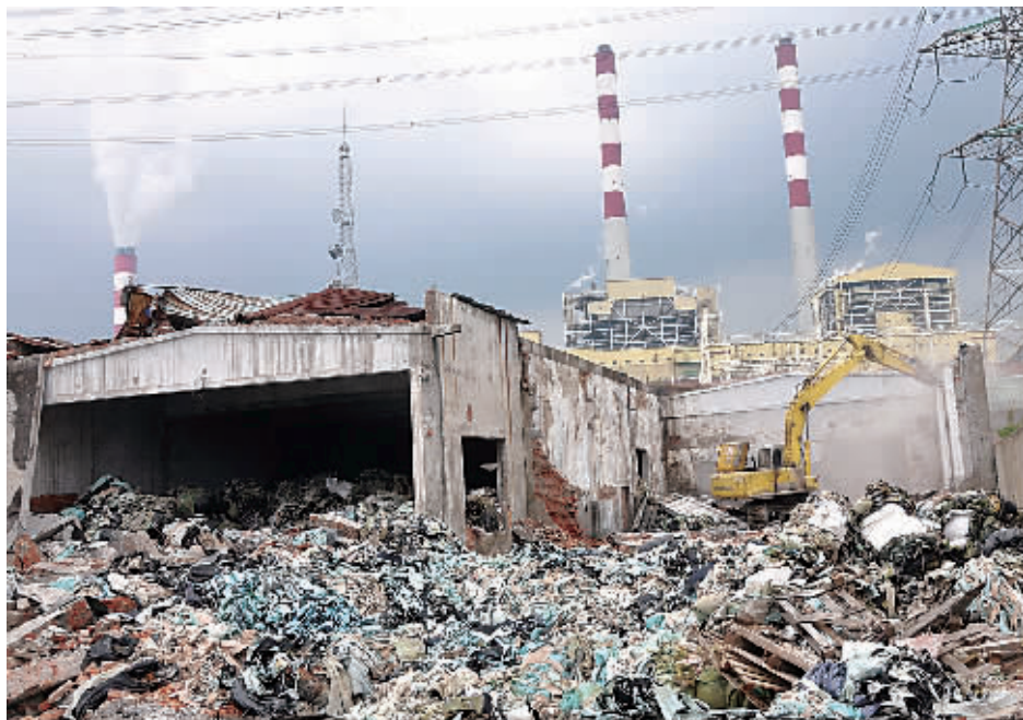
图为拆违现场。
