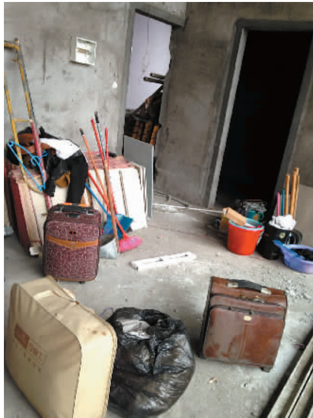
▲二楼东侧正在装修。(沈孙晖 摄)
