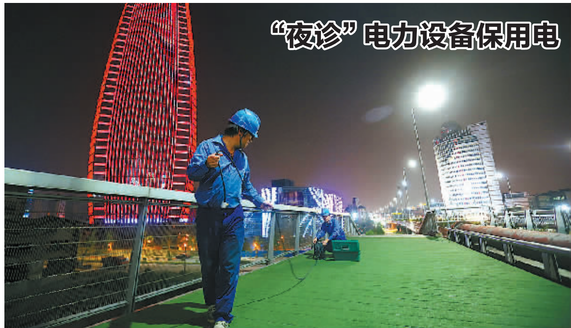
入夏以来，宁波用电负荷不断攀升，导致电网设备发热“中暑”，引发安全隐患。为此，宁波供电公司全面开展夜间低负荷时段检修，重点加强迎峰度夏期间的专业化巡视，确保高温天输电设备安全稳定运行。
