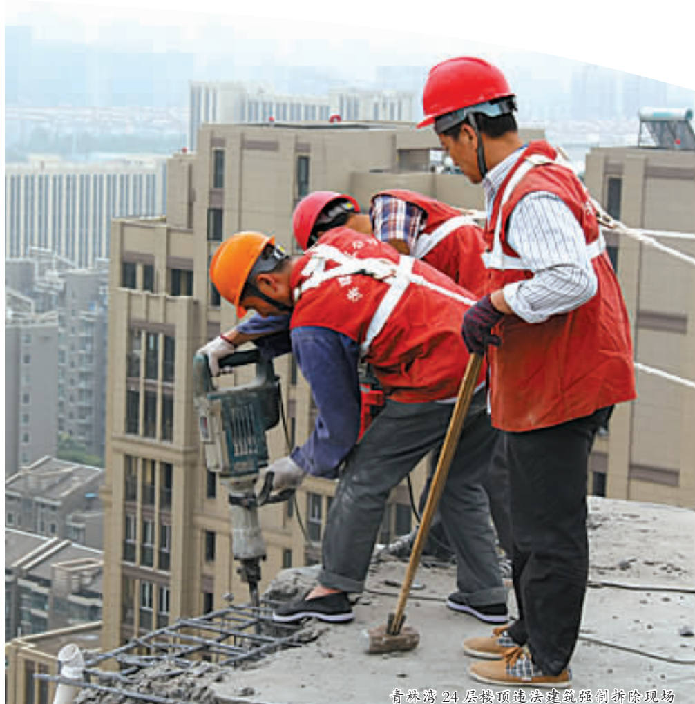
青林湾24层楼顶违法建筑强制拆除现场
