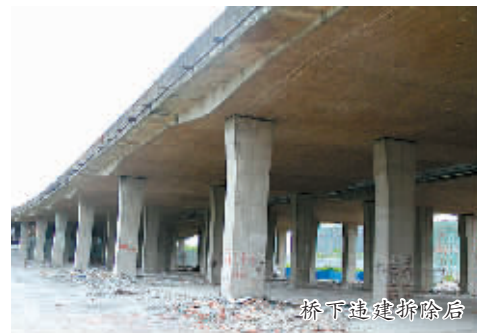
桥下违建拆除后
