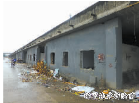
桥下违建拆除前
