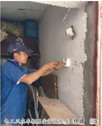
电工正在车棚里安装插座。(王伊婧 摄)
