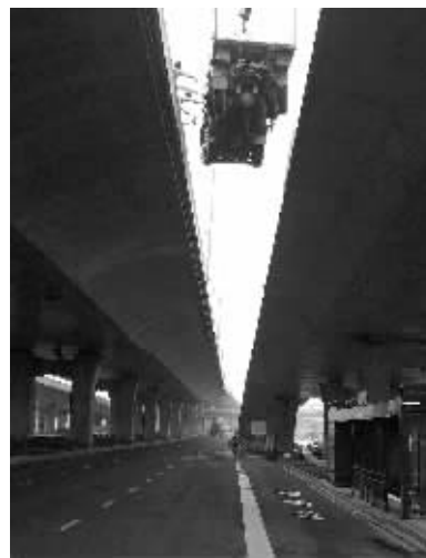
图为吊车现场。(李达勇 摄)
