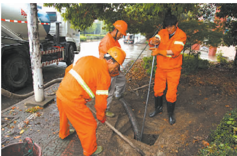
骆驼街道组织力量为地处低洼地段的骆驼村疏通下水管道,解决了村民们的一块“心病”。
