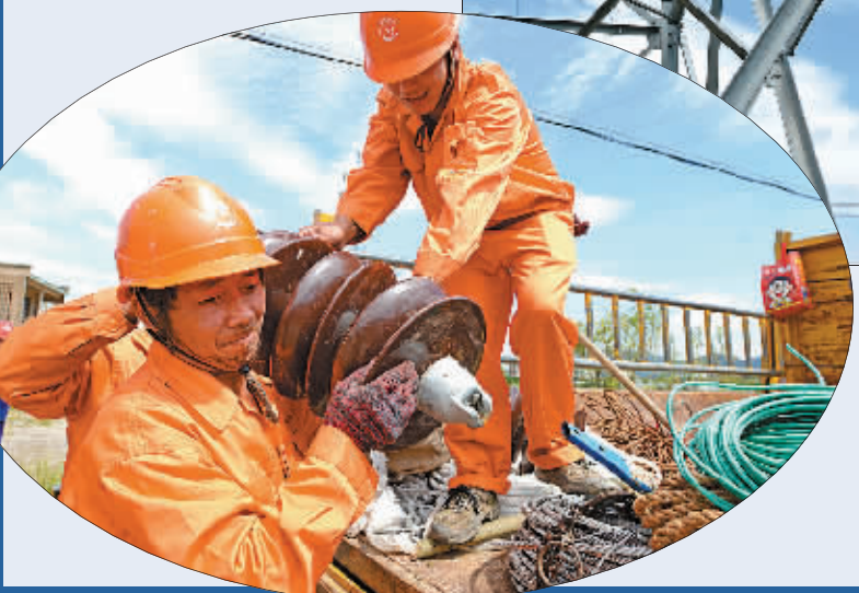
昨天上午,象山县鹤浦供电所施工人员在该镇黄金盘村更换因强热带风暴“凤凰”过境而受损的绝缘体。截至中午12时,象山所有受灾线路与停电用户恢复送电。(徐能 俞莉 陈光曙 摄)
