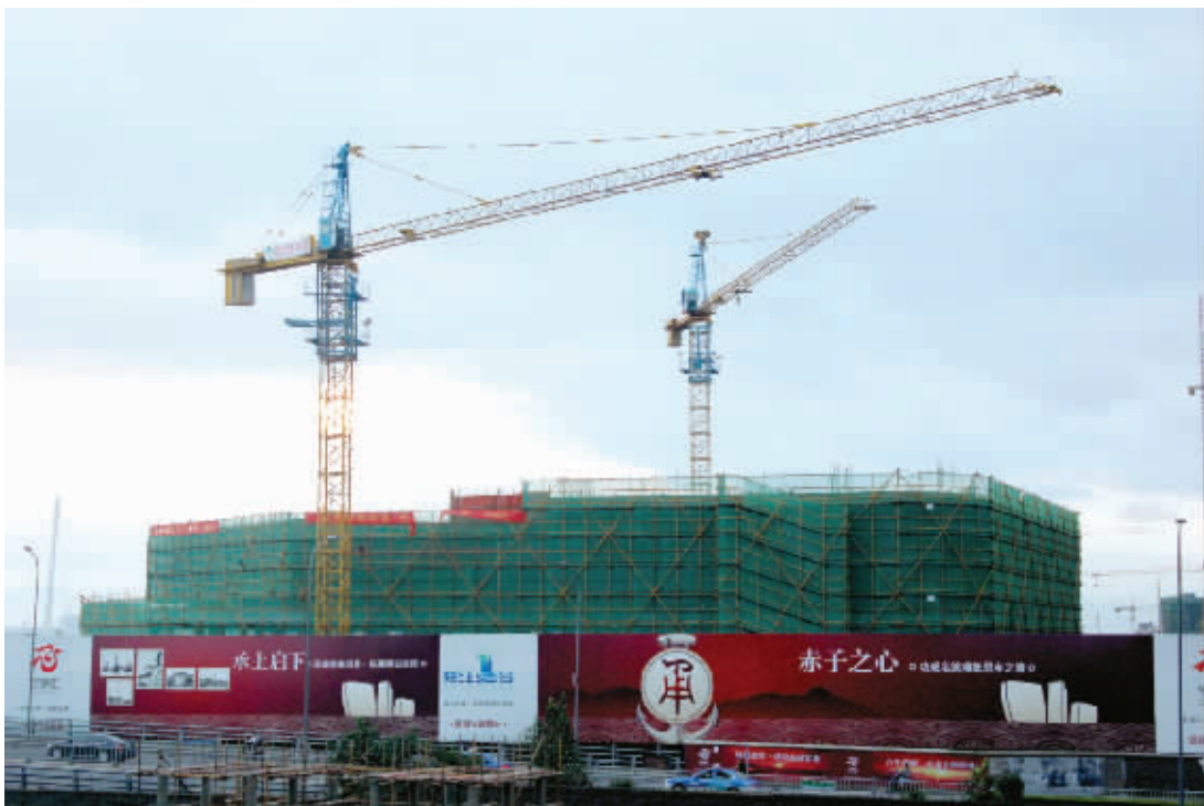
慈孝浙商回归项目——深圳宁波商会姚江一号建设现场。
