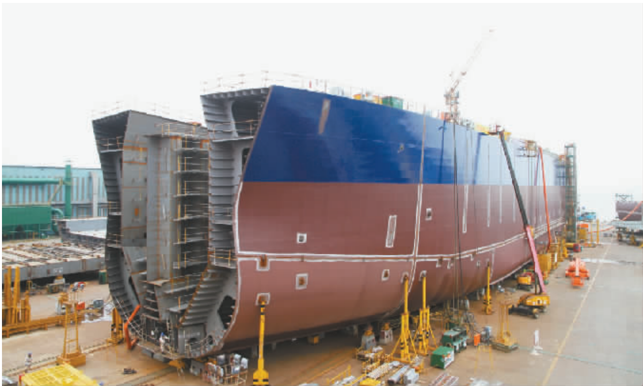
图为宁波三星重工在建的首艘成品油船。(刘沛 摄)
