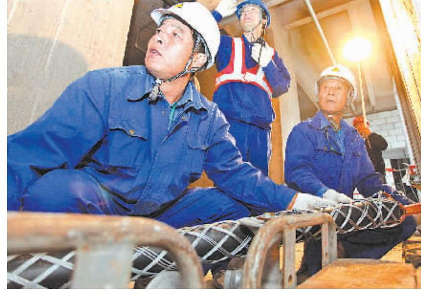
在东部新城宁波航运中心内，宁波电力配网公司施工人员正在用绞线机把缺口粗的主电缆通上高楼。
