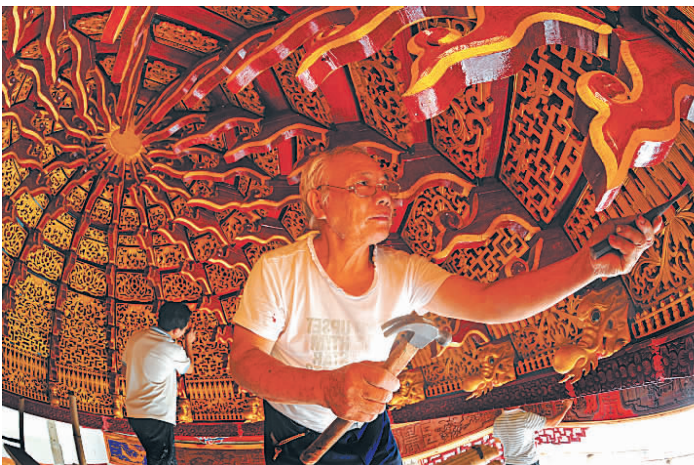
▲在一市镇东岙村,现年68岁的周衍柱老人正在修葺即将完工的戏台核心构件——藻井。从18岁开始,他一直从事这一行业。
