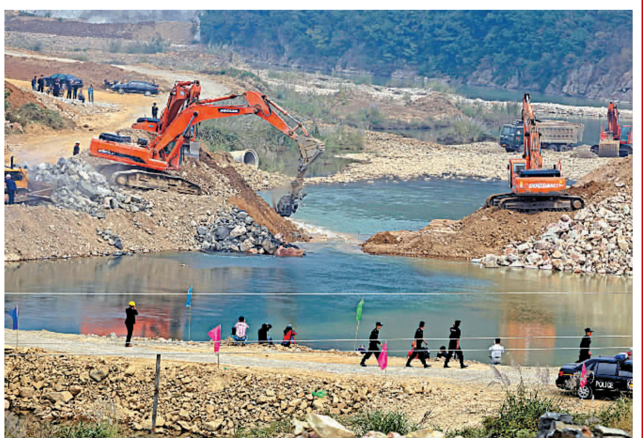
钦寸水库工程大坝围堰截流合龙现场。
