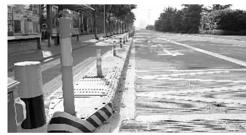
图为改造后的四明路公交车站。
