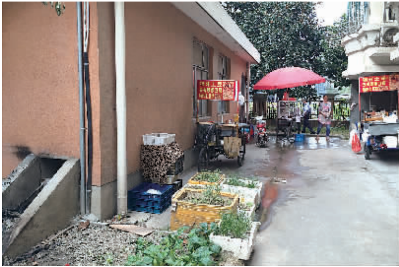
南裕小区配电房旁停放的烧烤车，左侧墙面黑色处为着火点。(王伊婧 摄)
