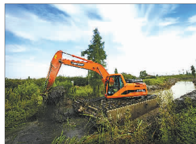
水陆两栖挖掘机清理河道
