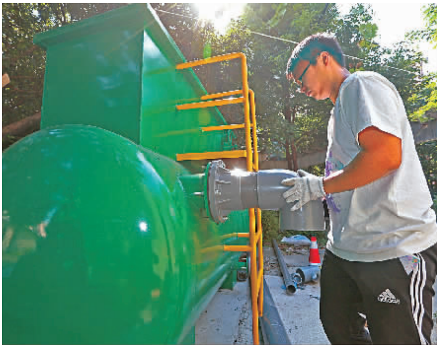
图为技术人员在调试机器。
