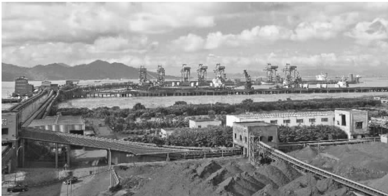
图为北仑港区铁矿石码头全景。
