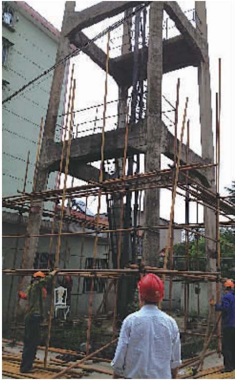
工人在拆除水塔。(通讯员供图)
