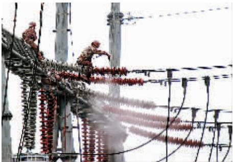
11月19日，工作人员在江苏省泰州市境内的500千伏泰兴变电站喷涂“防霾”涂料。近日，江苏省电力部门组织人员对全省9座500千伏变电站以轮停方式，对主电网500千伏及220千伏绝缘设备上喷涂一种可防止污秽颗粒物附着的新型涂料，可大幅降低雾霾影响，保障电网安全供电。
