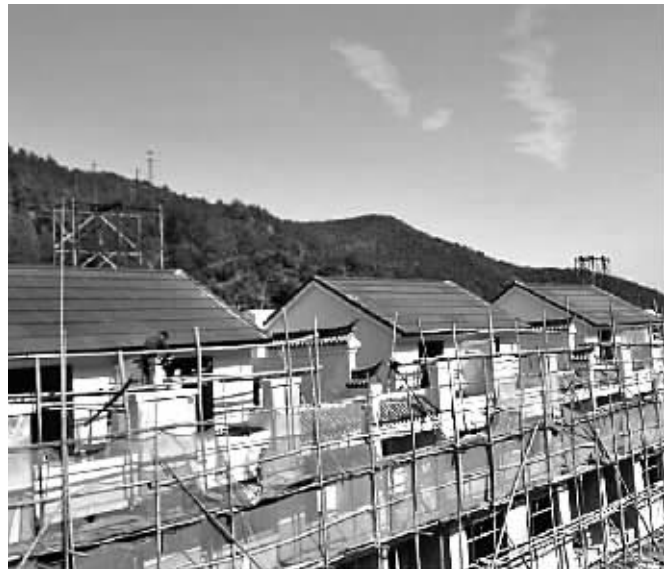
图为屋顶上铺设的深蓝色发电瓦片。(冯瑾 摄)
