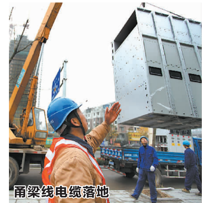
甬梁线电缆落地
