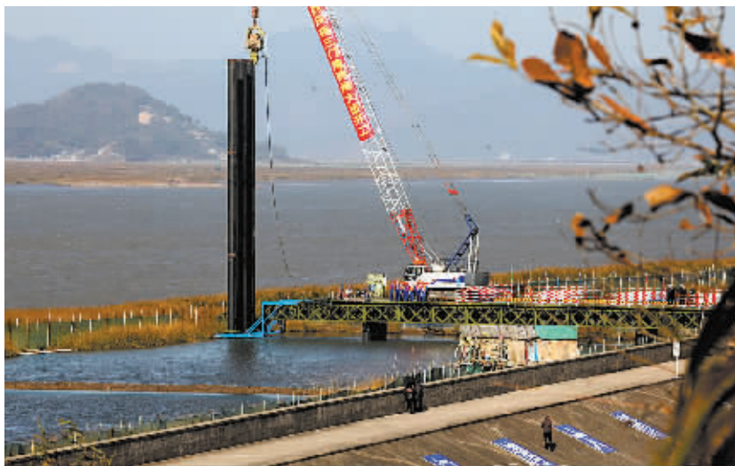
图为三门湾大桥开工现场。
