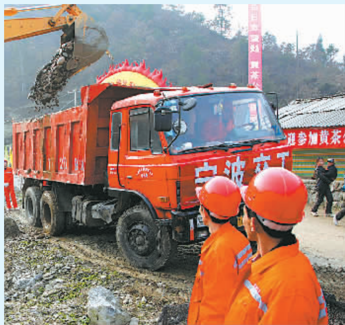
宁波建工集团在援建的青川县黄茶（黄洋—茶坝）公路项目施工。
