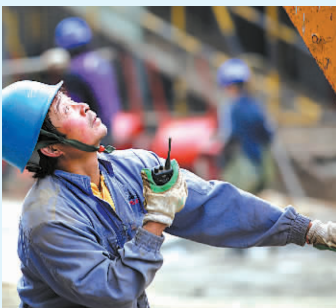
市建设集团工人在我市援建的青川县广电中心工地施工。
