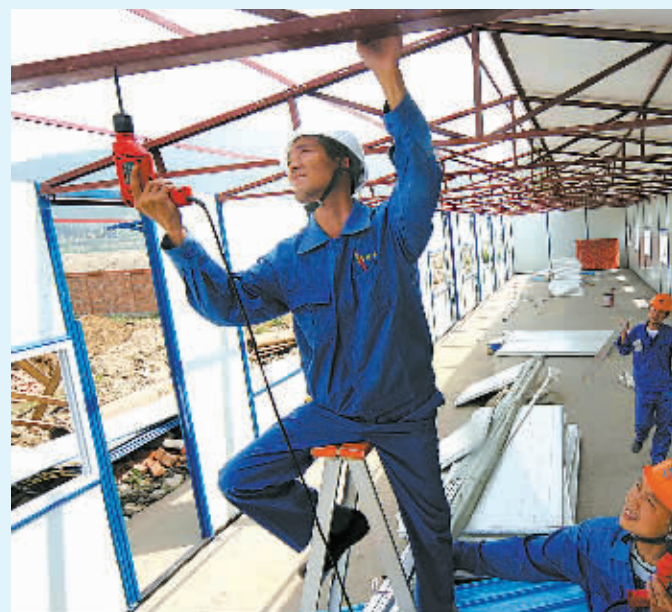
宁波建工集团援建人员正在剑阁县拐枣坝灾民临时安置点安装活动板房。
