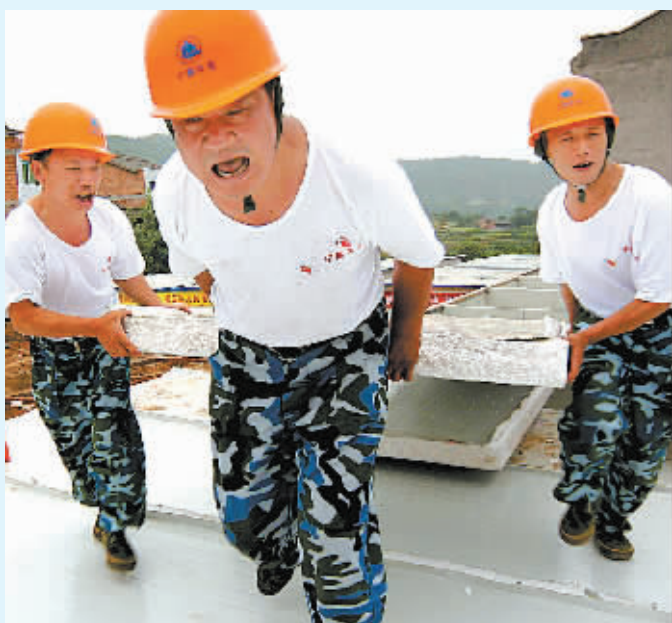
市住宅集团工人在张王乡安置点施工。
