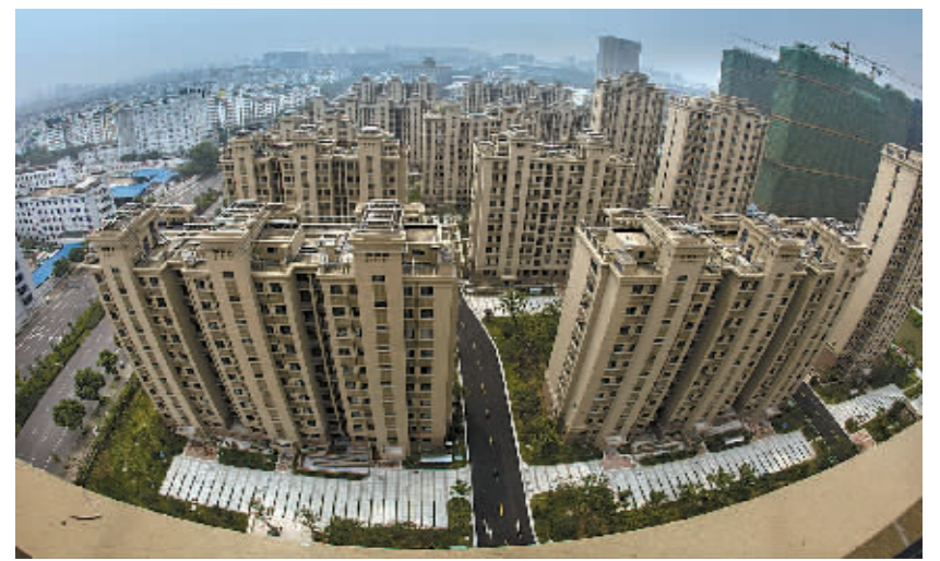
望春街道舒心苑小区800多套安置房已完成抽签定位。(胡建华 张黎升 摄)
