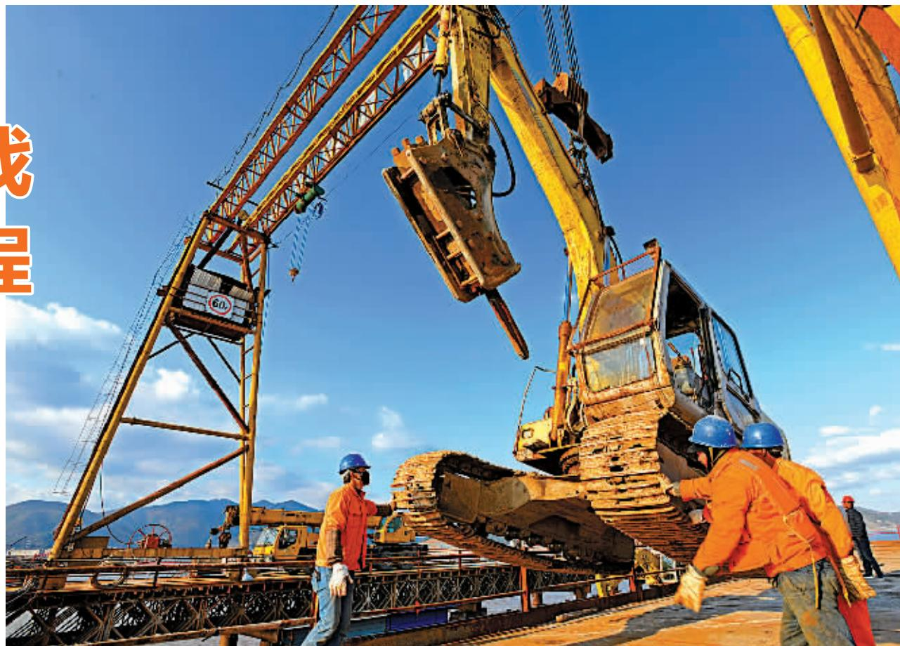
昨天下午，在省重点工程——梅山春晓大桥项目现场，施工人员正在准备主墩承台浇筑作业。作为我国首座纵移双层开启式桥梁，该项目总投资11.7亿元，预计2016年建成，目前主桥墩承台钢套箱已吊装完成，开始进入水面工程施工阶段。
