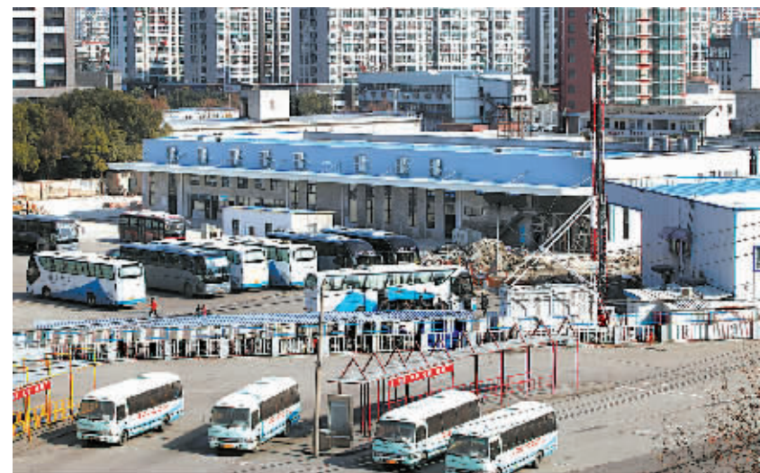
北移30米的汽车东站内外装修基本完成,停车场硬化施工已近尾声,计划在春运前投入使用。(胡建华 孙幼俊 摄)
