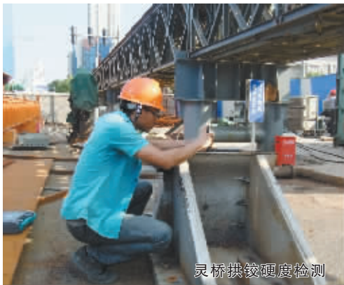
灵桥拱桥硬度检测
