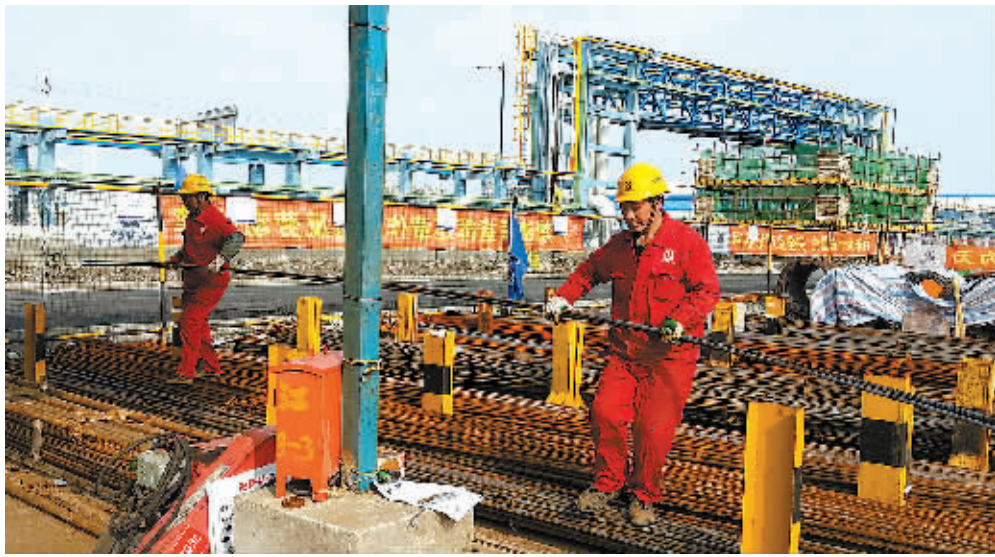
污泥干化焚烧工程建设现场，工人正在抬钢筋筋笼。（冯璋 摄）
