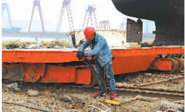
涉渔“三无”船舶拆解现场。
