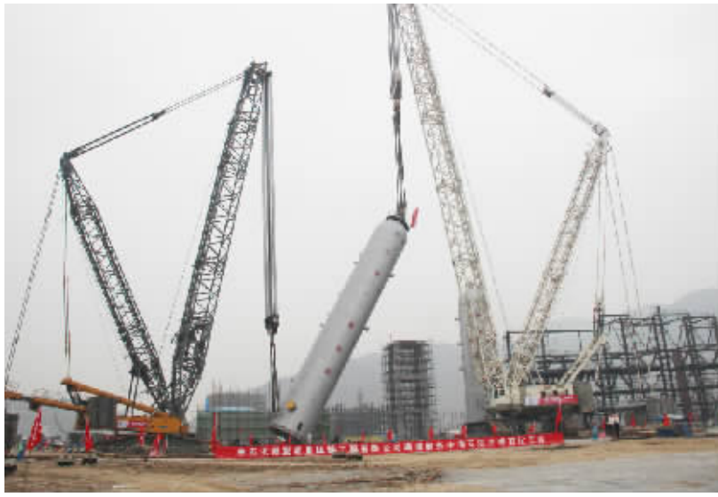
图为正在吊装中的加氢精制反应器。(怀永德 摄)
