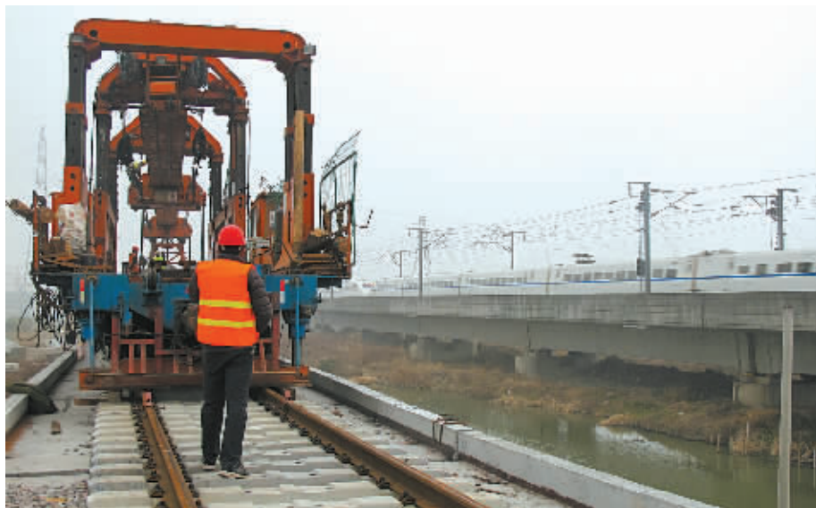
铁路货运北环线施工现场。(张燕 李新民 摄)
