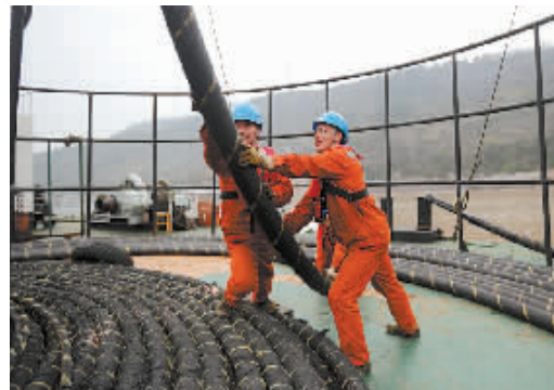
宁波电网首条海底电缆对接象山檀头山岛风电场，电力工作人员在海缆作业船上整理海缆。
