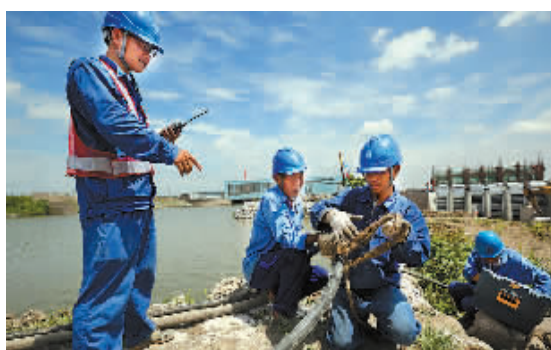
电力工作人员为大型水泵站建设施放电缆。
