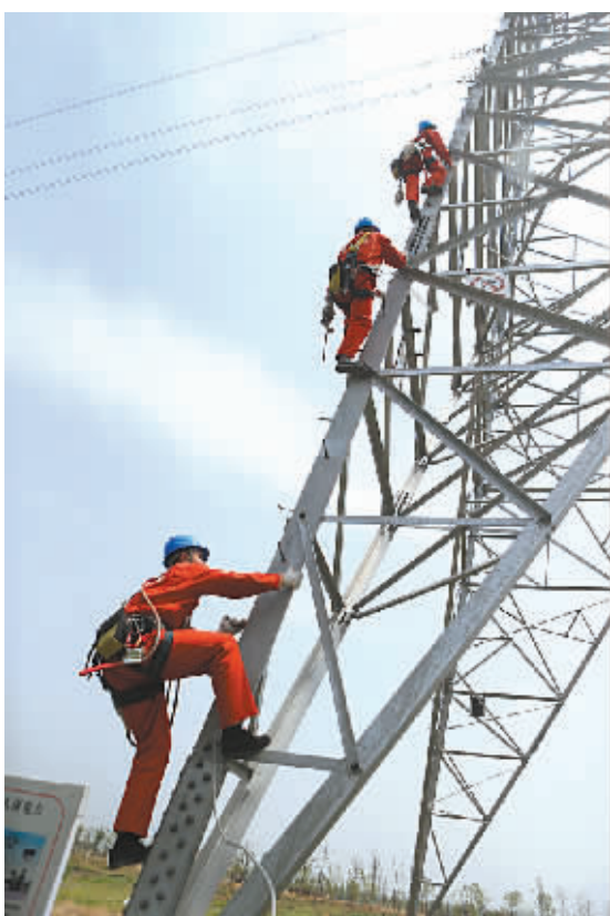
电力工作人员检修铁塔。
