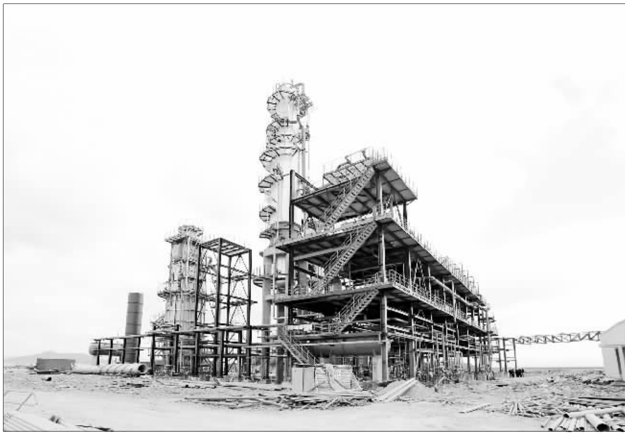
图为宁波千和环保公司在建的国内最大油污水综合利用处理装置。(记者孙红军 摄)
