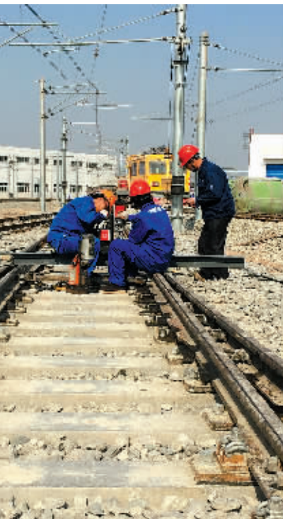
黄隘车辆基地施工人员加班作业。（冯璋 蔡明杰 摄）
