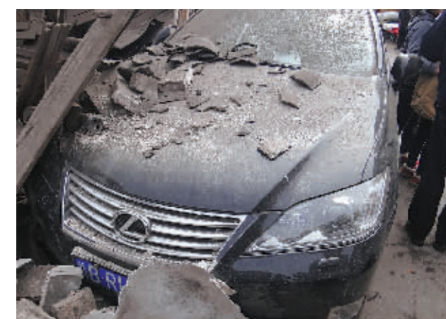
图为事故现场。
