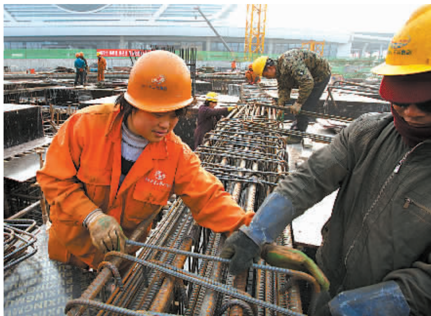
图为建设中的铁路宁波站北广场工地。(胡建华 摄)
