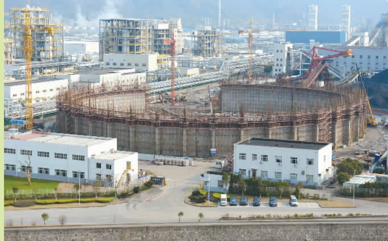
本报讯（记者李平 通讯员薛新春）近日，记者在万华化学（宁波）码头有限公司原煤炭堆场区域看到，一座直径120米的圆形煤仓墙体部分已浇筑到11米高度。这座高70米左右的圆柱形煤仓计划在今年三季度建成投用，另一座同样的煤仓将于2016年底建成投用。
