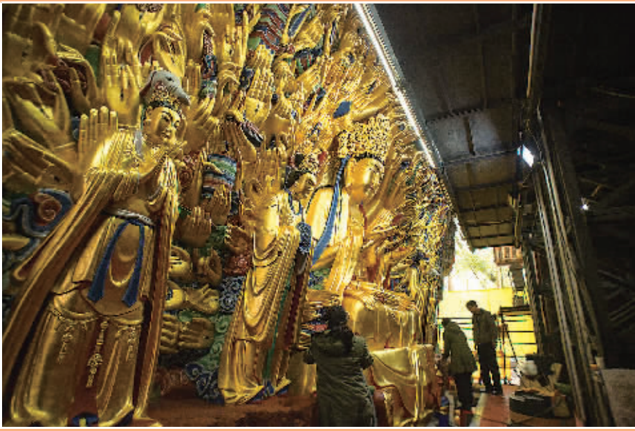
3月24日，在贴金工序完成后的千手观音造像前，几名工作人员在底层区域工作。日前，重庆大足千手观音造像修复工程贴金工序已经完成，彩绘修复进入最后的底层区域。整个工程已完成超过90%的工序。按照计划，修复后的千手观音造像将于2015年6月正式竣工，与游客见面。(新华社发)
