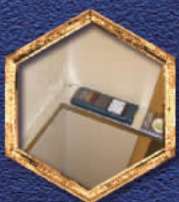
手工靠尺衡量每一堵 墙面的平整度
