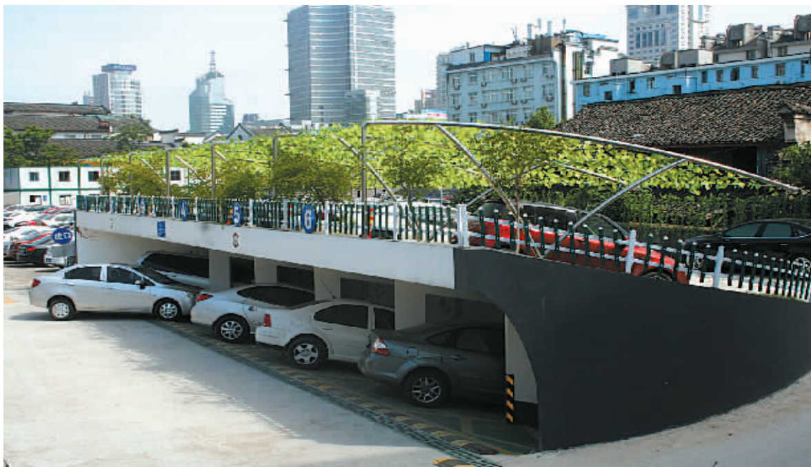
斜向泊车系统实景图。
