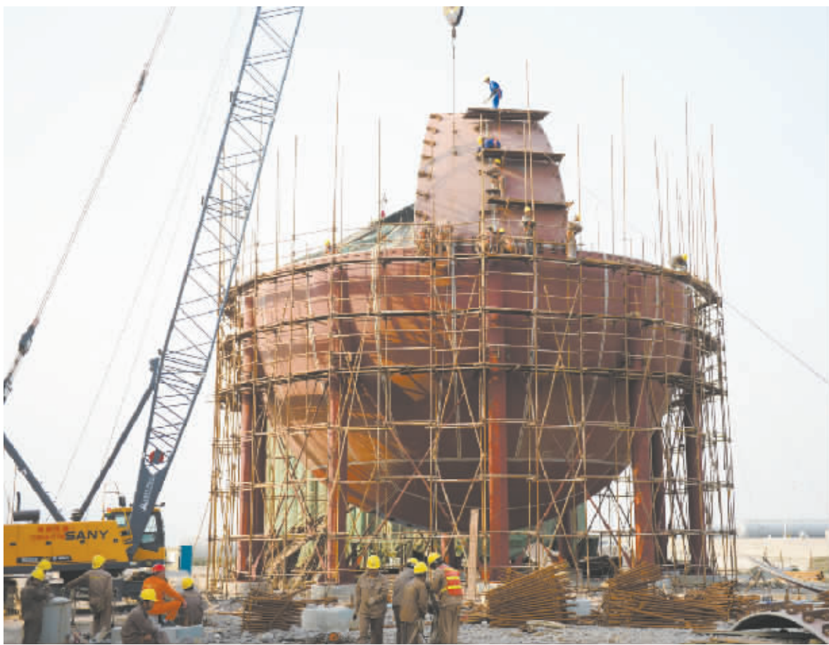
图为东华能源宁波福基石化丙烷资源利用一期项目建设现场。（何清 摄）
