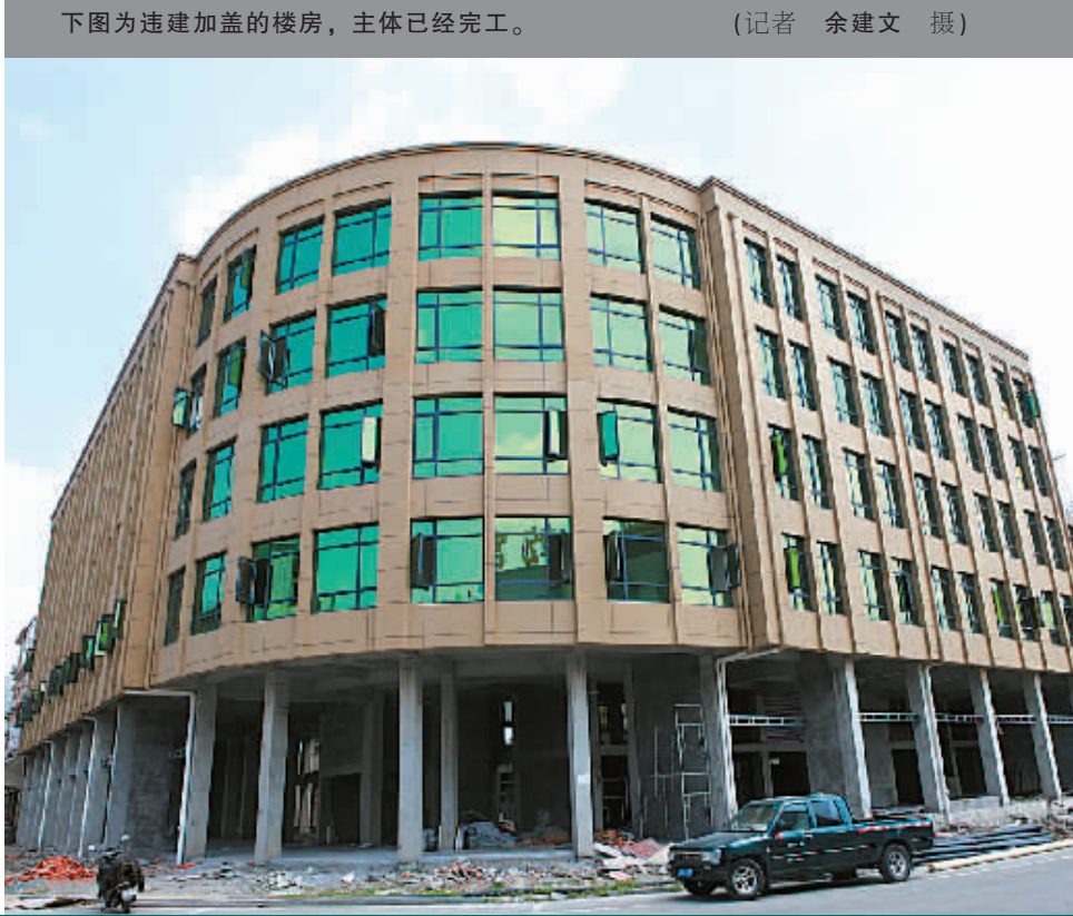
下图为违建加盖的楼房,主体已经完工。(记者 余建文 摄)
